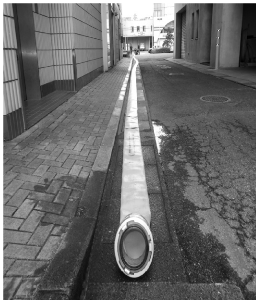
(写真 12) 庁舎敷地にホース延長し検証
